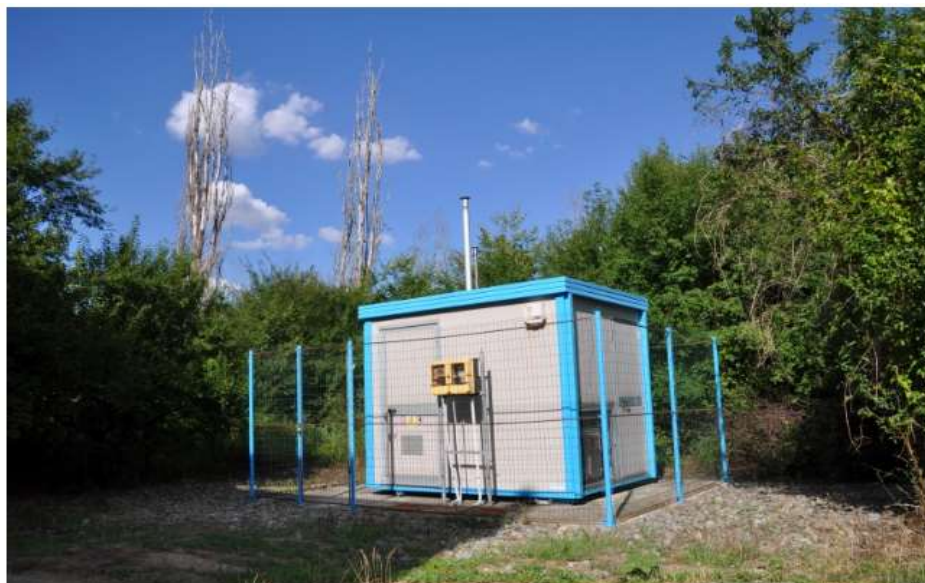
Figura 2-28 Stația automată de monitorizare a calității aerului Breasta DJ5
